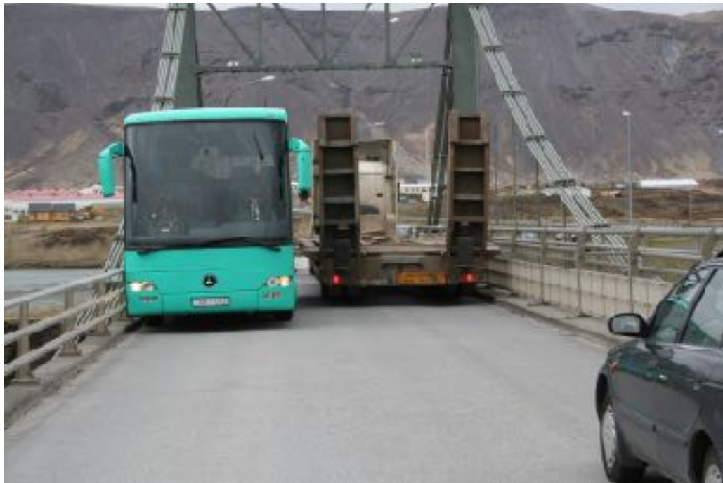
Mynd 2 Þrengsli á Ölfusárbrú.
